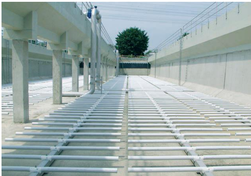
Tanque de arejamento com difusores de membrana tubular MAGNUM® FLEXSIL® .
